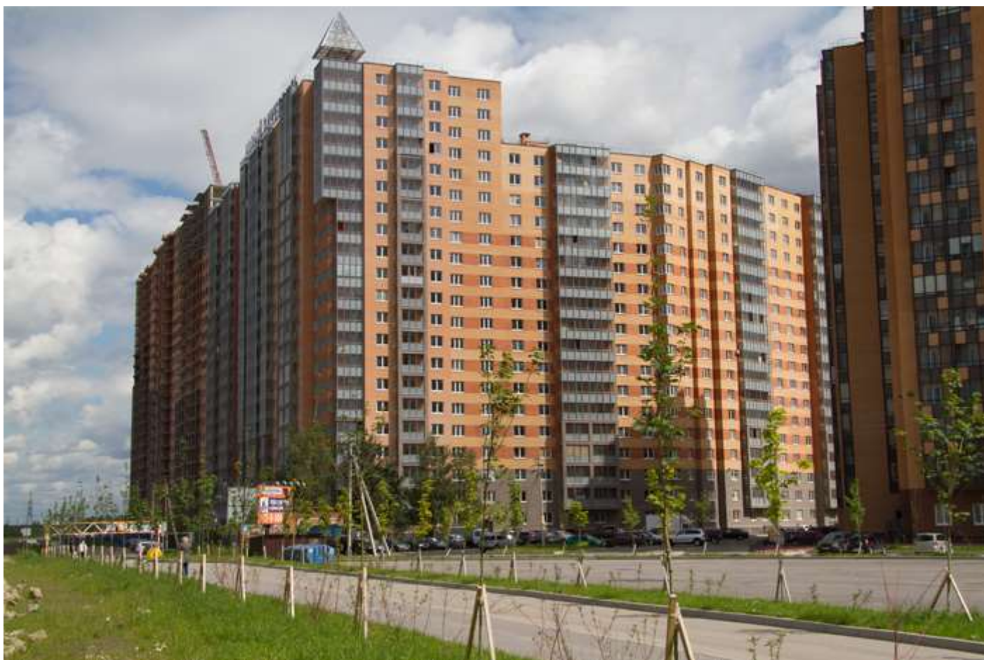
Вид с Областной улицы на секции (слева направо) 17-7
